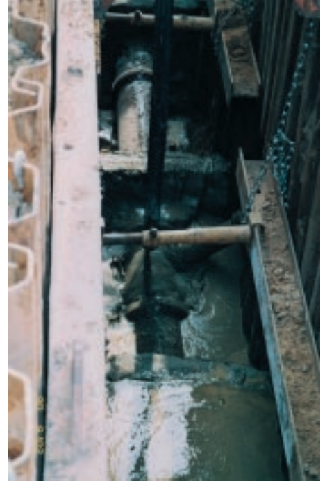
Einbringen des Flüssigbodens mit Betonpumpe.
