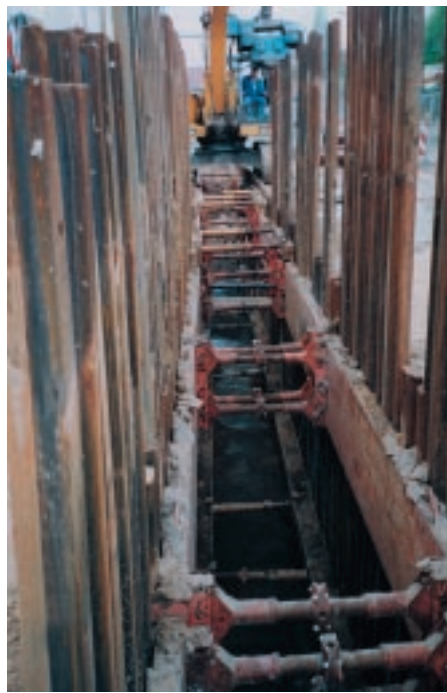
Ziehen der Kanaldielen.
