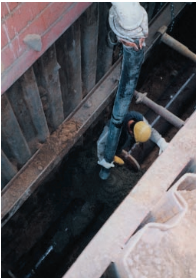
Einbringen der aus RSS-Flüssigboden steiferer Konsistenz Belastungsbänke.
