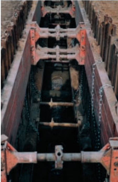
Die Belastungsbänke hatten die Aufgabe die Rohrleitung zu fixieren und gegen Auftrieb zu sichern.
