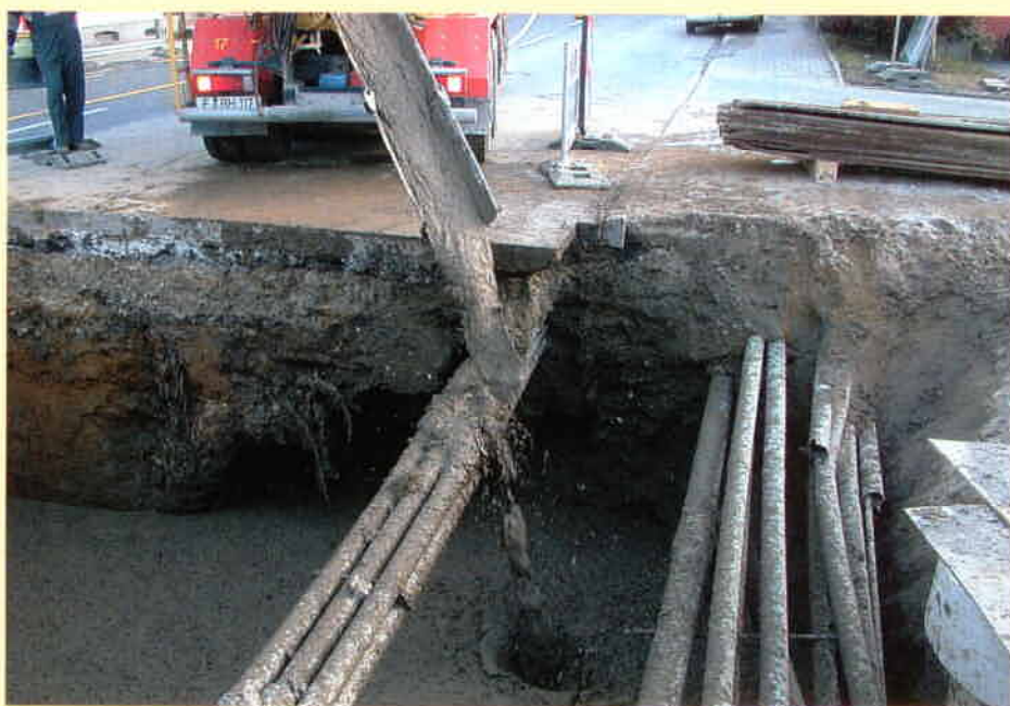
Bild 1: Einbringen des Flüssigbodens durch Transportmischer
