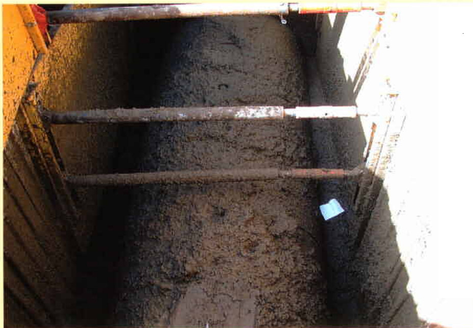
Bild 3: Kanalgrabenverfüllung mit Flüssigboden
