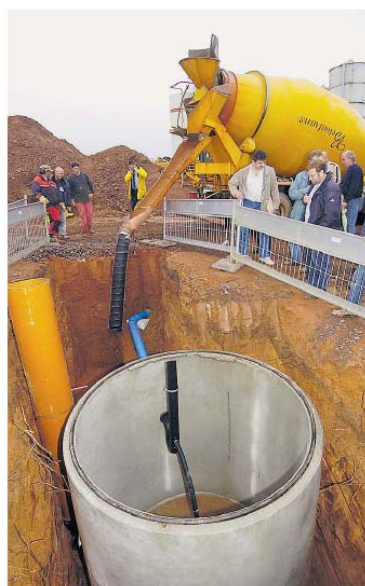
Mit Hilfe einer speziellen Methode wird Bauaushub aufbereitet und mit Zement vermischt, um danach als Füllmasse kostengünstig wieder verwendet zu werden. Foto: Andreas Engel
