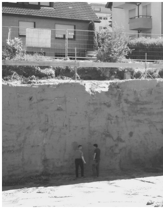
RSS-Wand einschließlich Bodenplatte aus RSS-Flüssigboden auf einer Baustelle in der Phase des Endaushubs der Grube.
