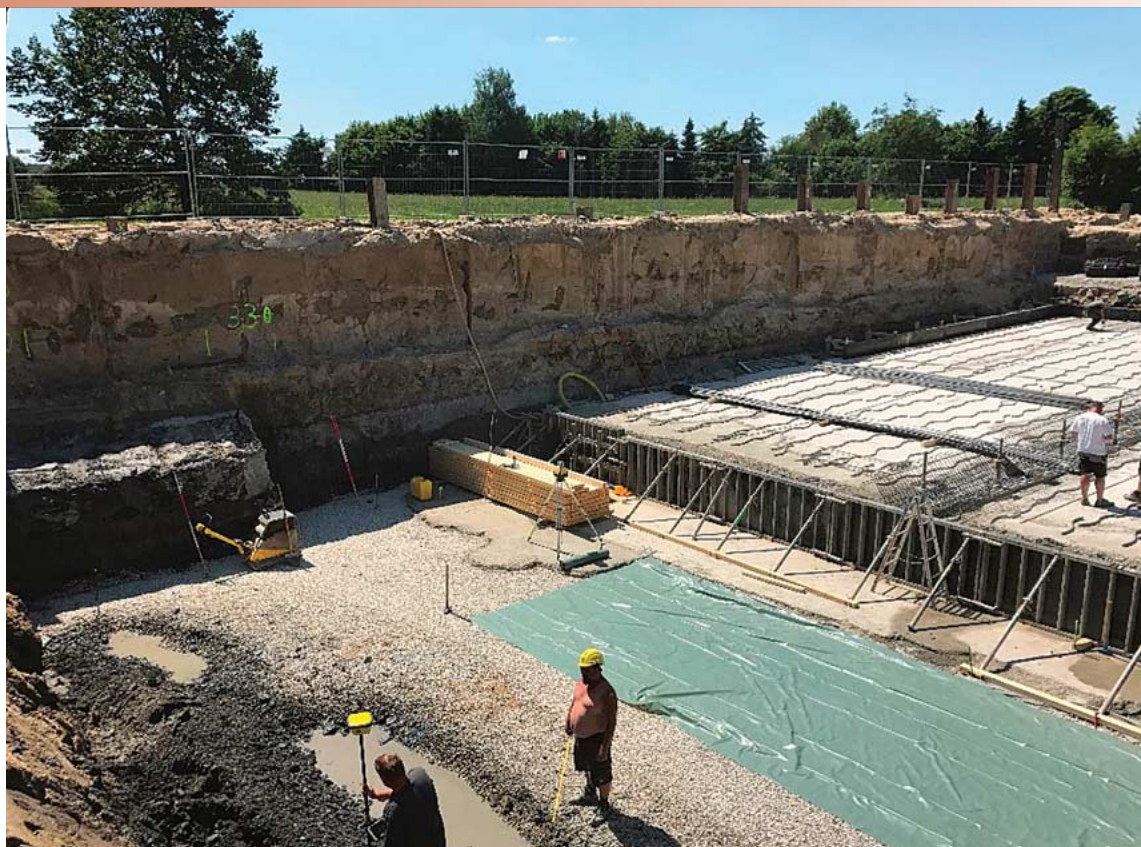
Der Flüssigboden wurde in Fürth vor Ort mit einer, den Vorgaben des RAL GZ 507 entsprechenden, Aufbereitungstechnik aus dem bestehenden Grabenaushub hergestellt und mit entsprechender Einbautechnik in den erstellten Graben der RSS-Wand eingelassen.
