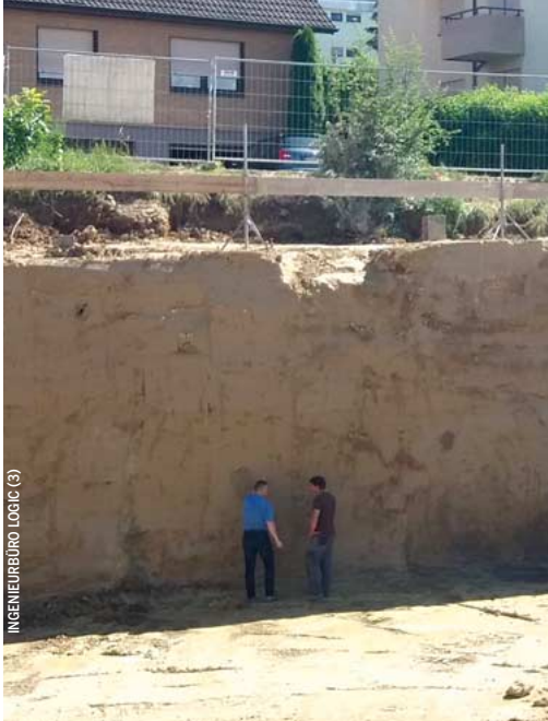
RSS-Wand auf einer Baustelle in Bad Rappenau – in der Phase des Endaushubs der Grube, d. h. der höchsten Belastung der RSS-Wand.
