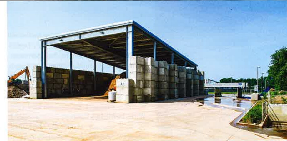
In den überdachten Boxen können auch schwach belastete Böden bis zur Schadstoffklasse Z2 zwischengelagert werden. | Foto: A. zu Eulenburg
