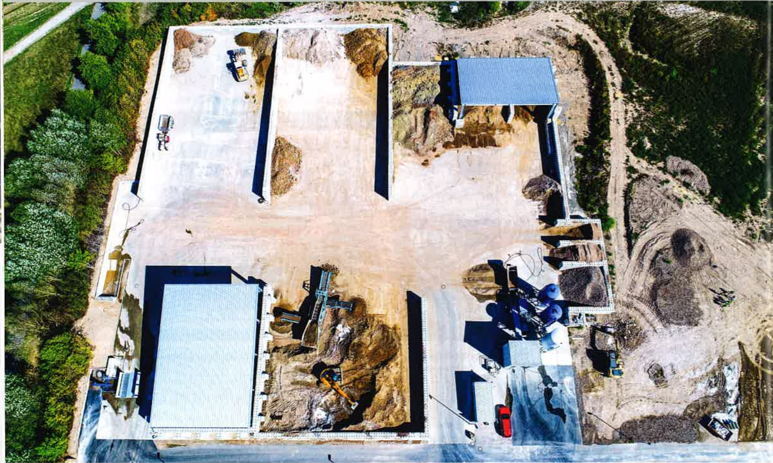
Das Bodenlager aus der Vogelperspektive. Vorne rechts ist die Flüssigbodenanlage zu erkennen. | Foto: KASSELWASSER
