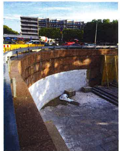
Vor der Verfüllung wurde der Tunnel beidseitig mit Wänden zugemauert. | Foto: FiFB Leipzig
