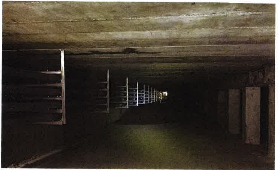
Über etliche Einfüllstutzen wurde der RSS-Flüssigboden eingeleitet (l.). Im Tunnel ist die Kabeltrasse sowie der sich langsam ausbreitende Flüssigboden zu sehen. | Fotos: FIFB Leipzig
