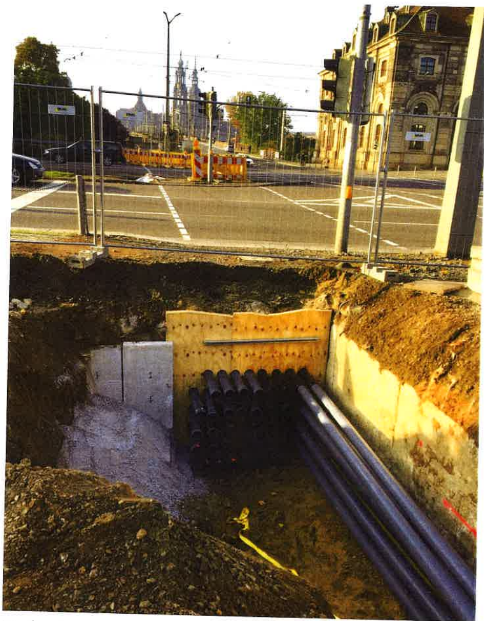
Im westlichen Bereich des Haupttunnels entstand eine großzügige Kabeltrasse. | Foto: FIFB Leipzig
