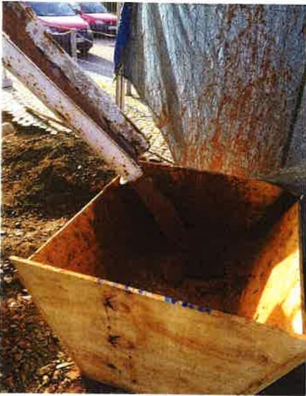
Über etliche Einfüllstutzen wurde der RSS-Flüssigboden eingeleitet (l.). Im Tunnel ist die Kabeltrasse sowie der sich langsam ausbreitende Flüssigboden zu sehen. | Fotos: FIFB Leipzig
