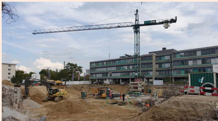
Direkt neben der Rennbahn-Klinik in Muttenz liegt die Baustelle der neuen Überbauung mit 125 Wohnungen, Gewerbeflächen und einer grossen Einstellhalle.
