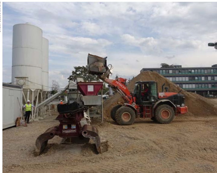
Das Beladung der Mischanlage mit einem Schaufelseparator direkt vor Ort. Das Bodenmaterial stammt aus der dahinter liegenden Baugrube.
