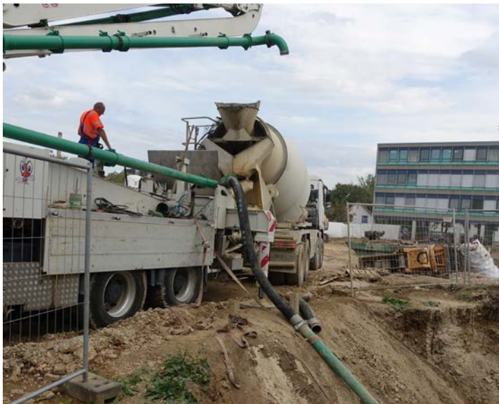
Das flüssige Material wird vom Fahrmischer mit einer Betonpumpe über Wandaussparungen in die Untergeschosse befördert.
