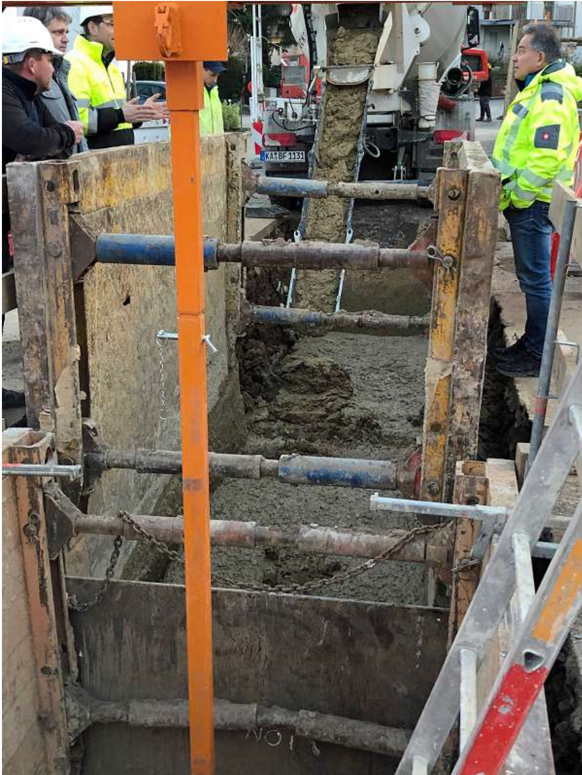
Die Kanalaufdimensionierung im Näherweg ist eine Prototypbaustelle für das ressourcenschonende Flüssigbodenverfahren. Foto: PM
