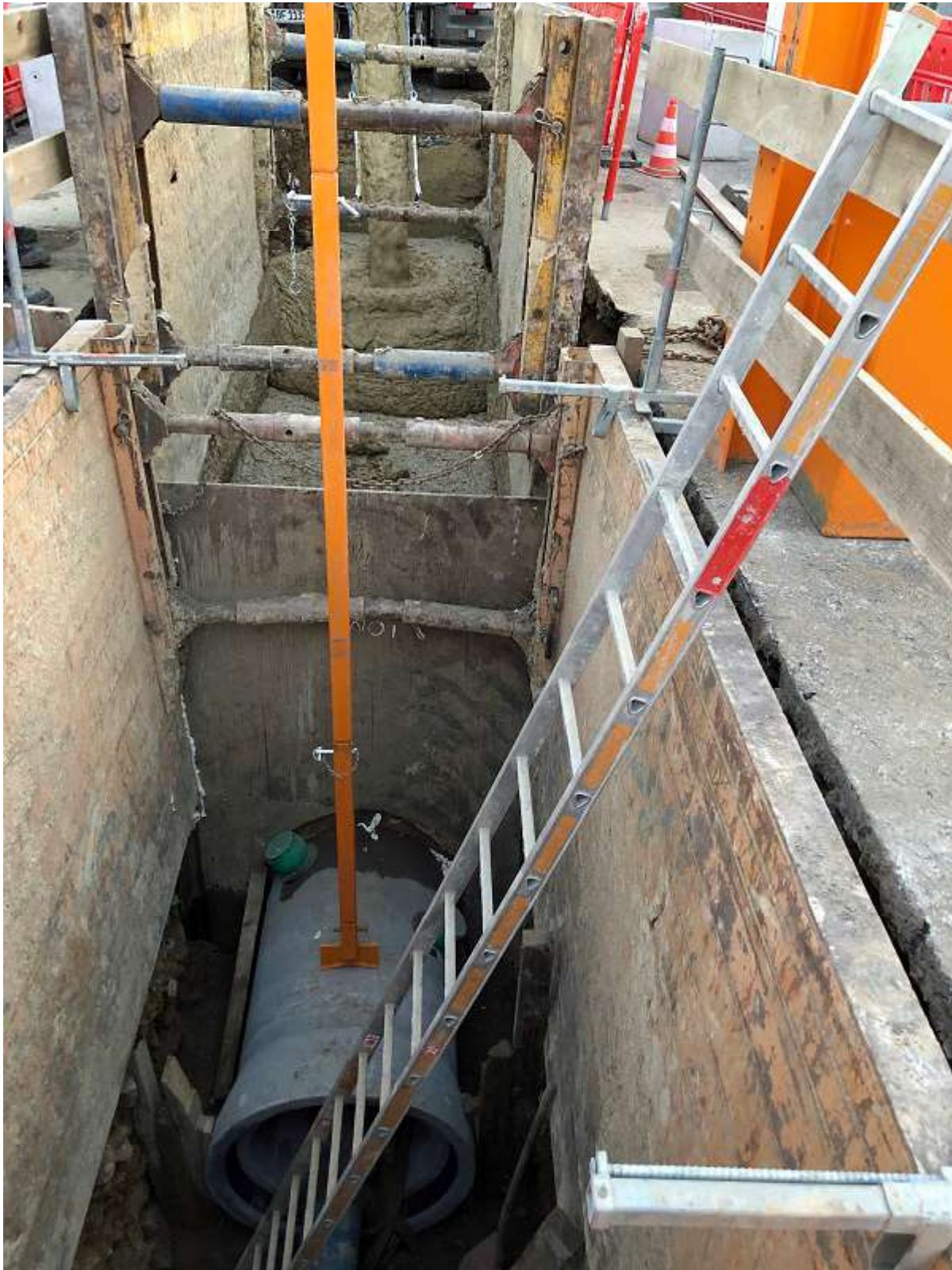
Beim Flüssigbodenverfahren wird das ausgehobene Material aufbereitet und wieder in die Baugrube eingefüllt. Foto: PM
