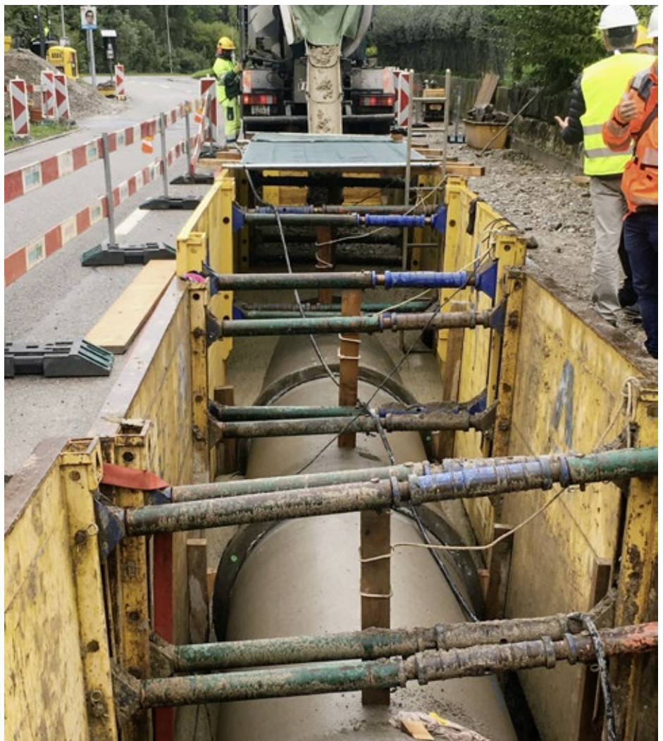
Verschiedene Anwendungen für Flüssigboden auf Schweizer Bautellen.
