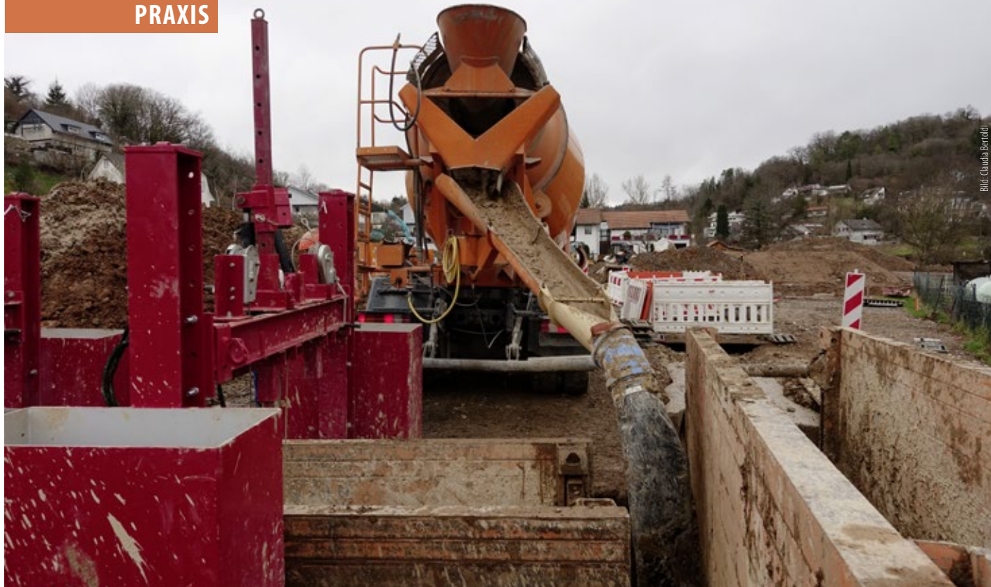
Flüssigboden-Einbau auf der Baustelle bei Rheinfelden AG..
