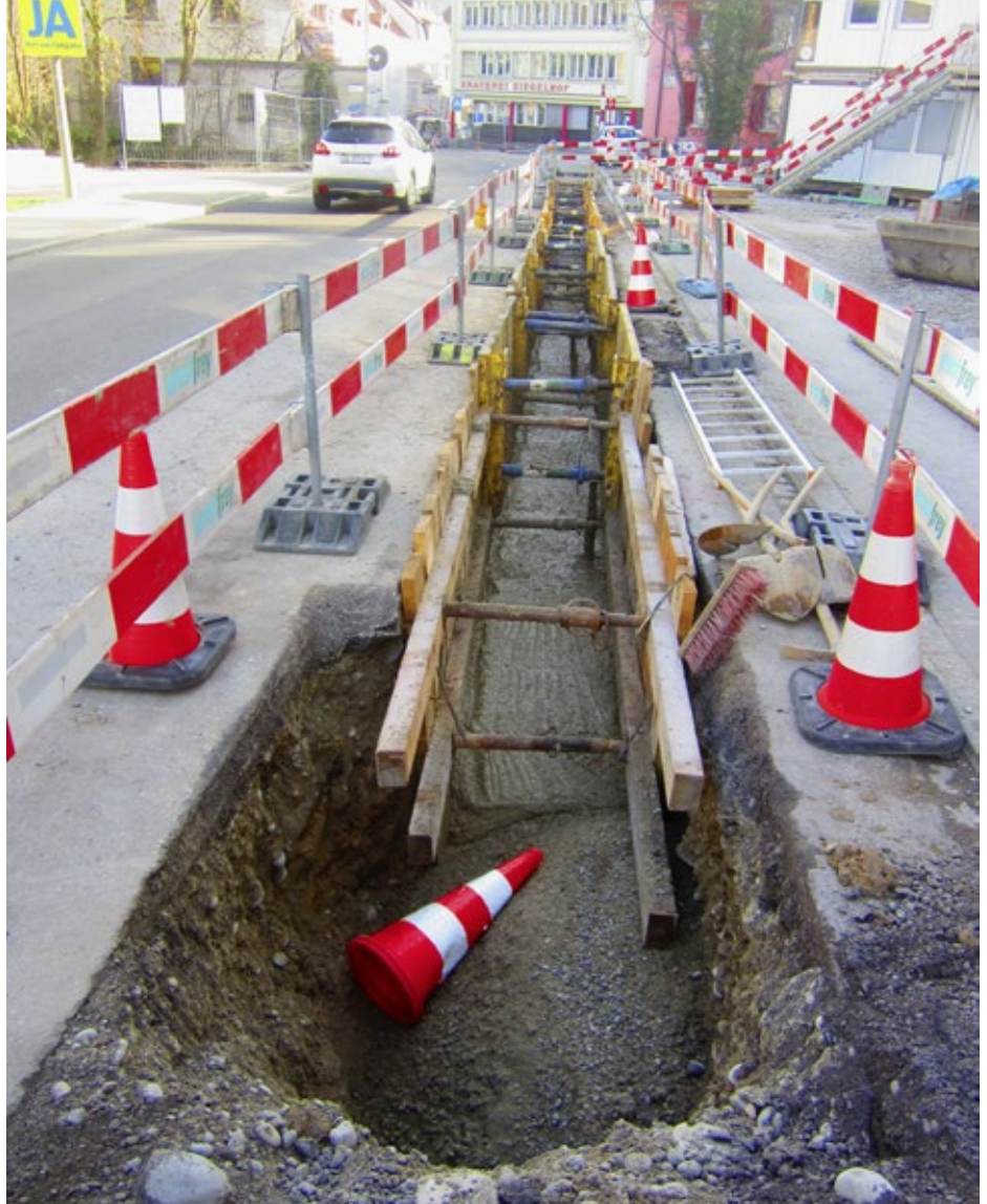
Verschiedene Anwendungen für Flüssigboden auf Schweizer Bautellen.
