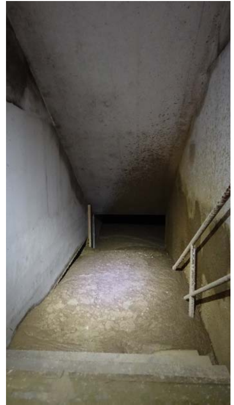
Im ehemaligen Treppenhaus ist der Verfüllvorgang am besten zu beobachten.
