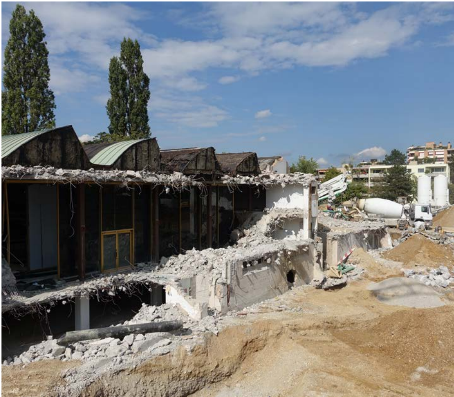
Noch ist das alte Gewerbegebäude nicht komplett rückgebaut. Die Verfüllung der untersten Geschosse mit Flüssigboden ist längst gestartet, das dritte Untergeschoss bereits komplett verfüllt.
