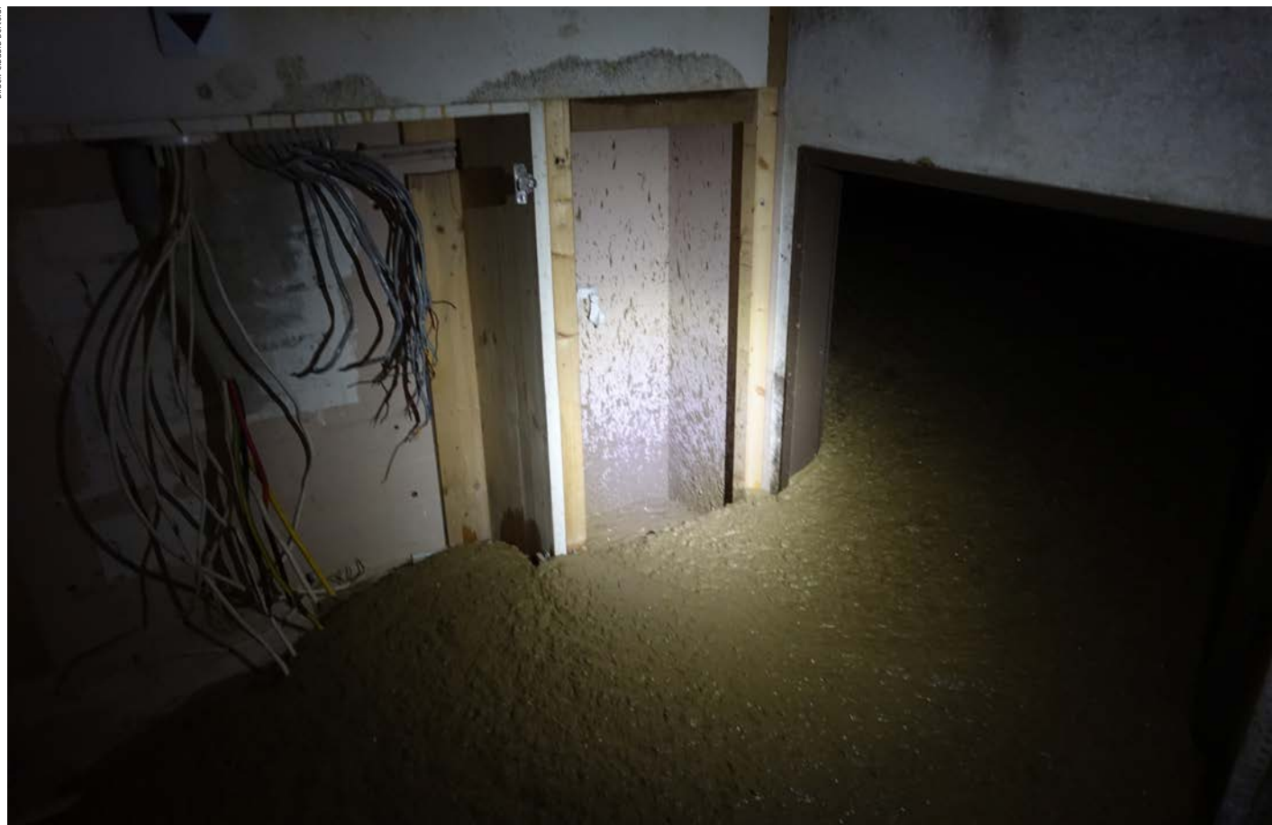
Baustelle Projekt «Muttenz Rennbahn»: das zweite Untergeschoss des ehemaligen Gewerbebaus wird mit RSS-Flüssigboden verfüllt. Die Masse breitet sich gleichmässig aus und nimmt bei der Erhärtung bodenähnliche Eigenschaften an.
