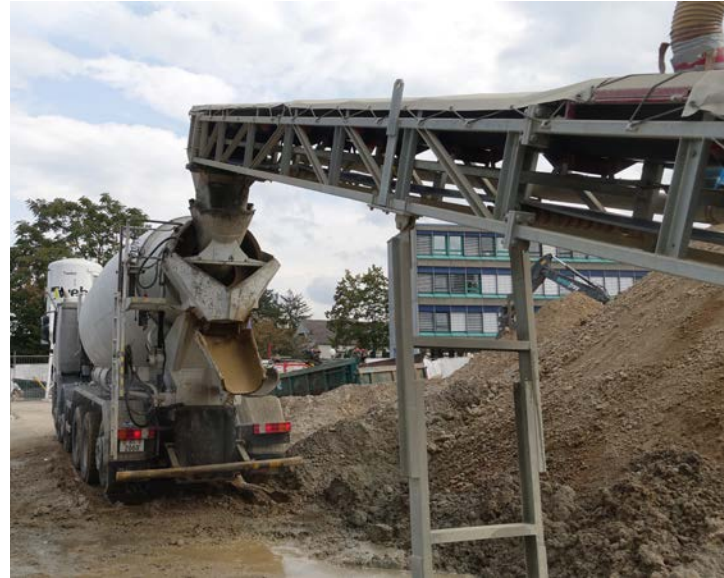
Das Bodenmaterial wird gemeinsam mit Compound und Zement über ein Band in den Drehmischer befördert und dort mit Wasser vermisch.
