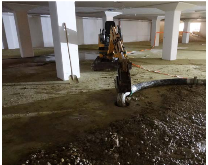
Der Verfüllvorgang erfolgt teils durch Kernbohrungen in der Bodenplatte des Untergeschosses. Sie wurden in Abständen von rund fünf Metern eingefräst.
