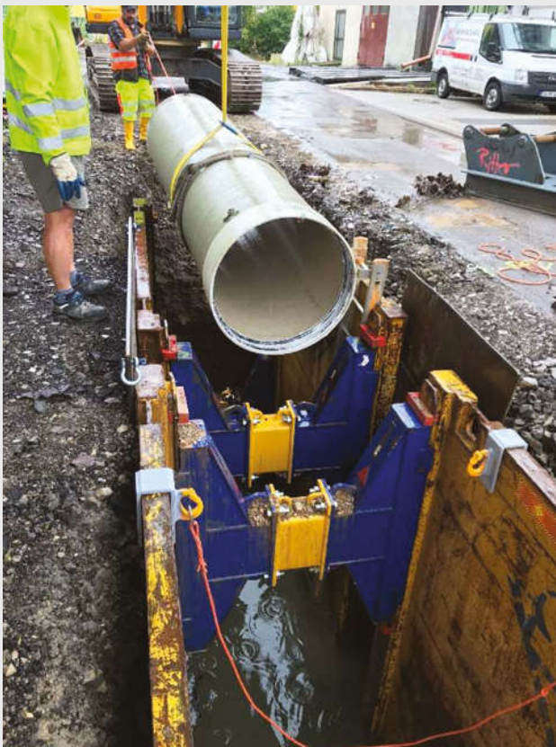
Bild 4: Bei der „Schwimmenden Verlegung“ wird das Rohr in den mit Grundwasser gefüllten Graben abgesenkt und mittels RSS-Rohrverlegehilfen am vorbestimmten Platz fixiert. Danach verdrängt der RSS-Flüssigboden das Wasser – kostenaufwändige Wasserhaltung ist hier nicht nötig
